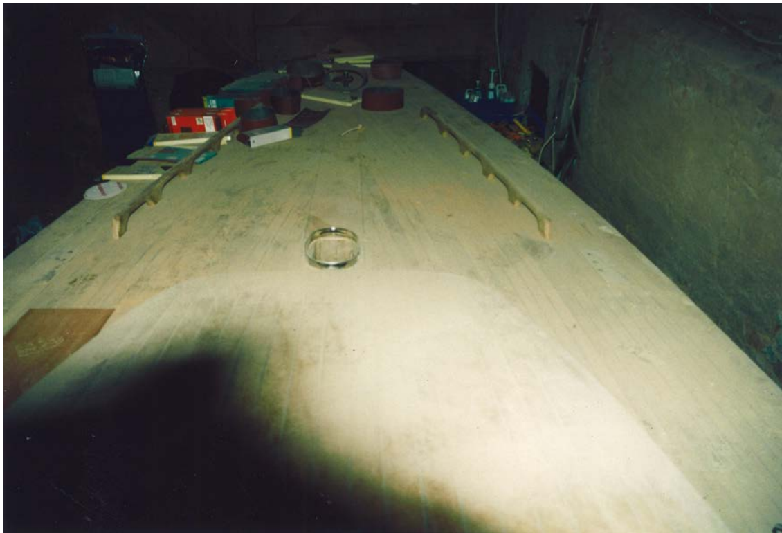
Bild 6: Bugbereich fertig geschliffen
