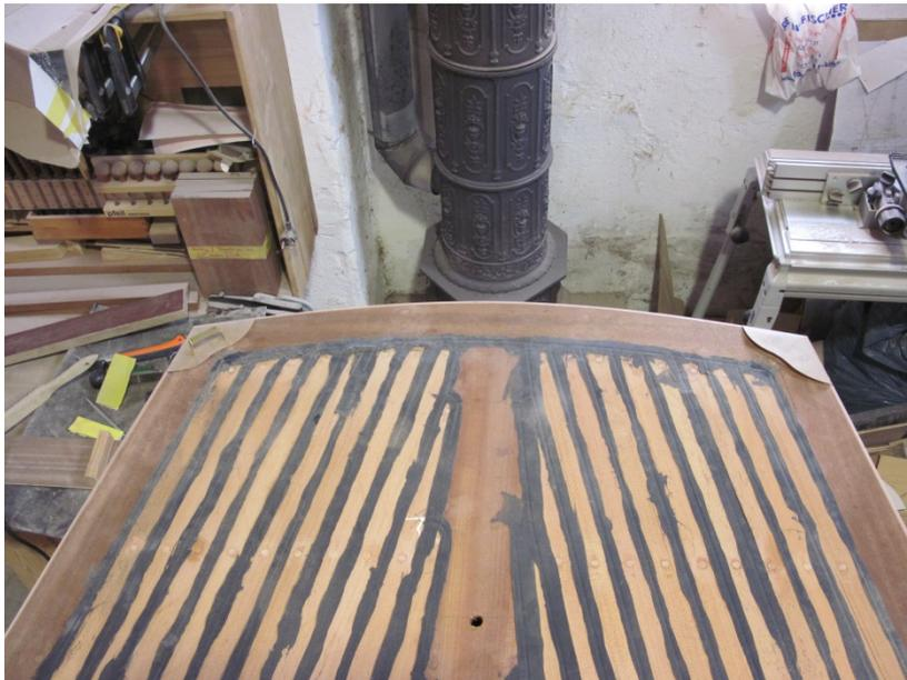
**Bild 40: Verguss der Fugen im Decksbelag**
