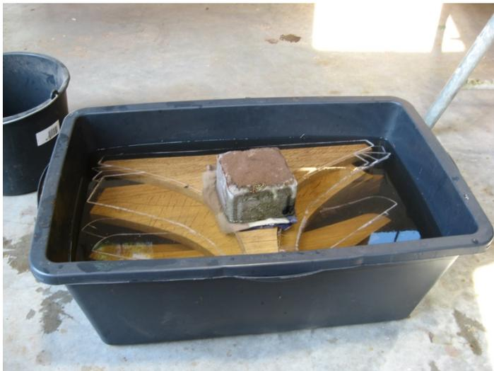
**Bild x: Wässern der Bodenwrangen, man beachte die Spuren der Aussenlinien auf der Wasseroberfläche nach mehrtägigem Wässern**
