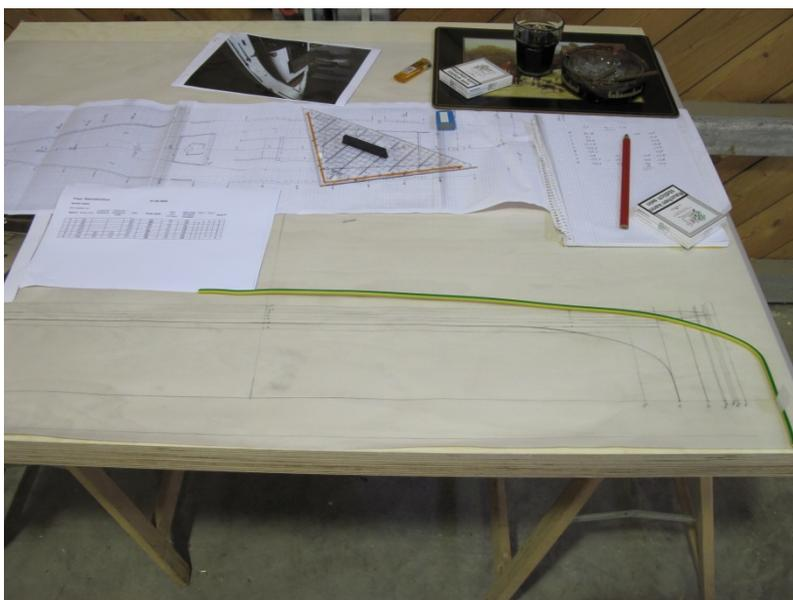
**Bild x: Übertrag der Straklinien für das Kajütdach**
